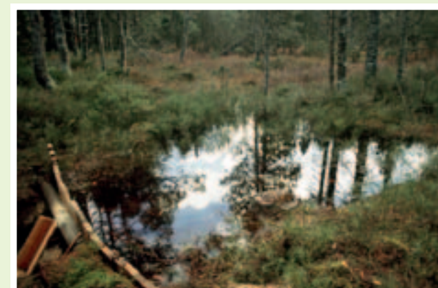
Horbacher Moor bei Dachsberg, Bau einer Sperre im Frühjahr 2007 mit frisch angestautem Wasser.
