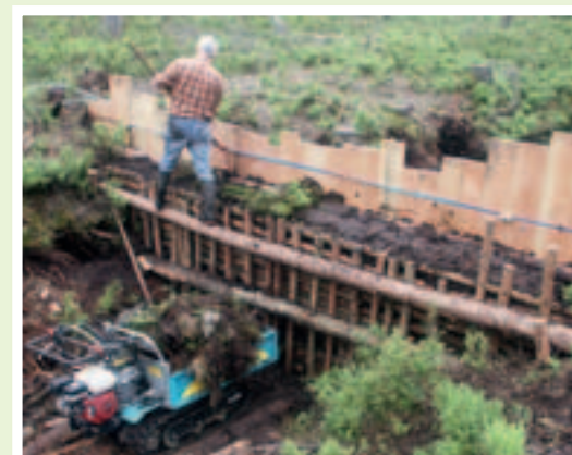
Manueller Bau einer großen Doppelsperre in Ibach
